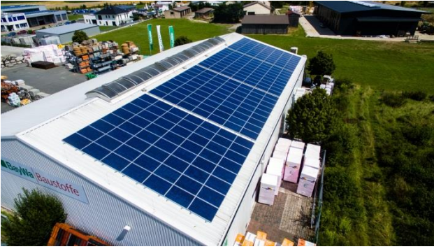
46 kWp Firmengebäude Eckental
