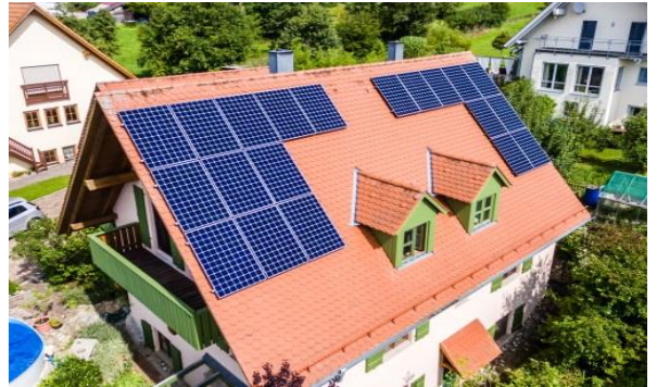
9 kWp Kirch Ehrenbach
