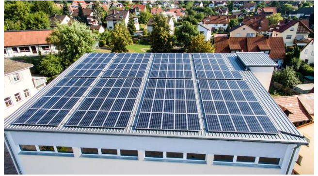
30 kWp Rathaus Weißenohre
