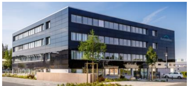
77 kWp Konzeptbau „CityCube“ Bayreuth
