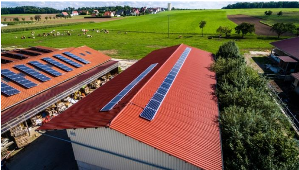
10 kWp Firmengelände Kalchreuth
