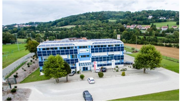
92 kWp Fassadenanlage Firmengebäude Weißenhohe
